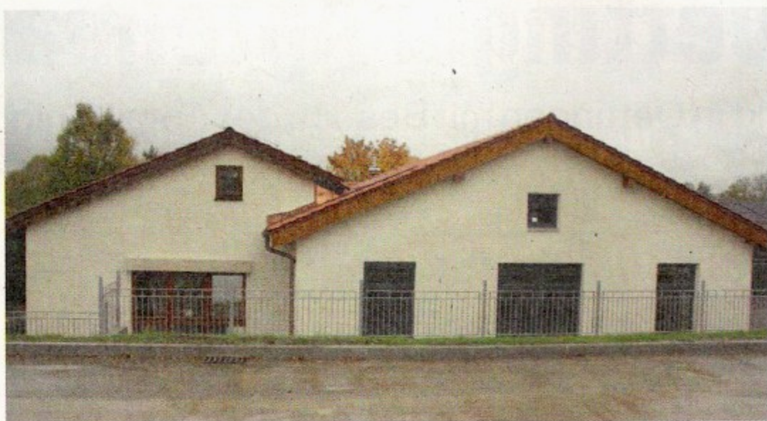
Der Erweiterungsbau (rechts) passt sich hervorragend an das restliche Gebäude an. Foto: Beckmann
